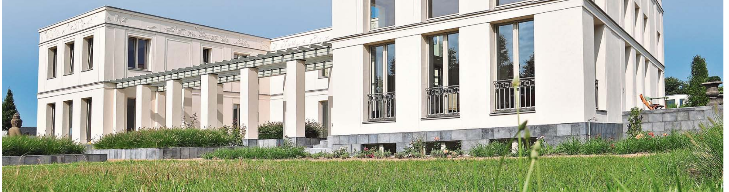
Klare Struktur in Anlehnung an eine klassische Villa zeigt dieser Bau in Potsdam – sogar mit einem umlaufenden Fries
