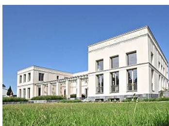
Imposant Die Villa R. beeindruckt durch die symmetrische Bauweise
